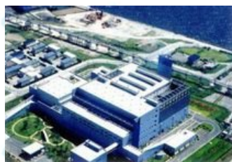
浮島処理センター (川崎市のごみ焼却処理施設)
